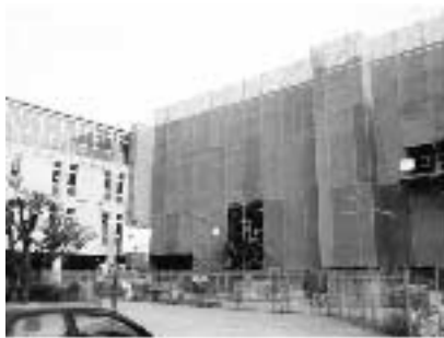
湯河原小学校C棟耐震大規模改修工事
