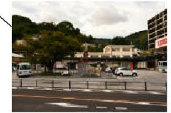
■地域生活基盤施設 駅ロータリー広場整備事業
