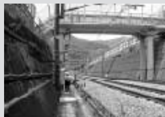
【新幹線跨線橋改良事業】 第2宮下跨線橋(明許繰越)と第1宮下跨線橋の一部の耐震補強・落橋防止工事を実施しました。
