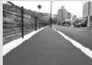
千歳通り2号線道路改良事業 歩道及び街路灯を設置し、利便性・安全性を高めました。
