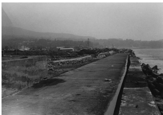
海岸埋立地護岸復旧工事
