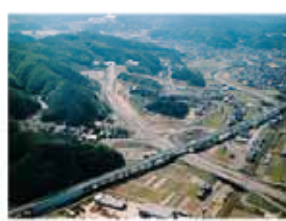
環状道路の整備
