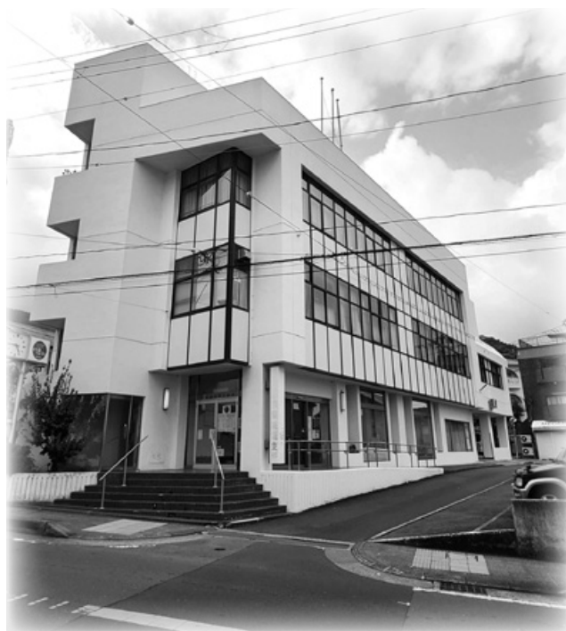
耐震改修などを施工する城堀会館
