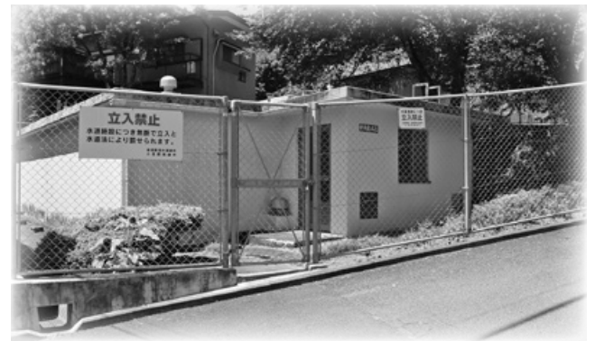
城堀簡易水道組合の配水池（中央配水池）
