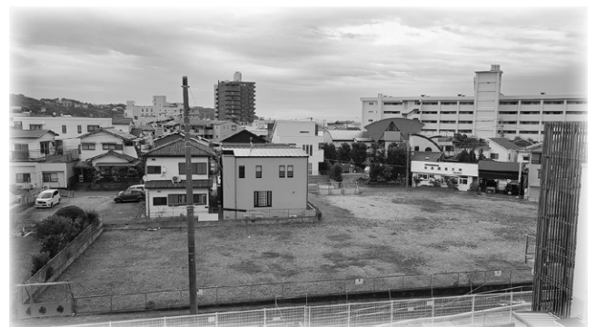
整備工事が行われる新若宮公園
