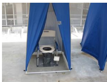
非常用マンホールトイレ （甲府市ホームページ）
