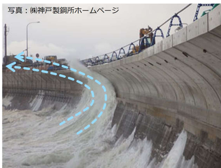
図 4.3 大型波返し工のイメージ図
