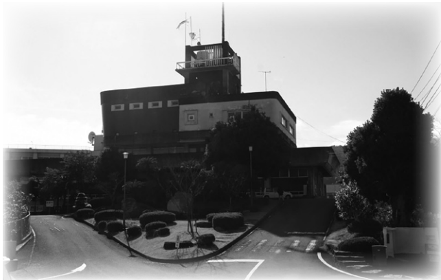
昭和37年に建築された第1庁舎
