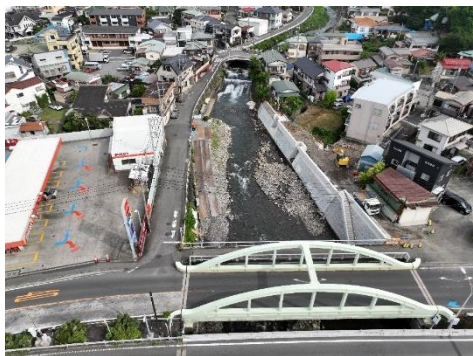
新崎川護岸嵩上げ工事
