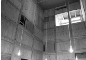
◀1階から見る吹き抜けの様子
