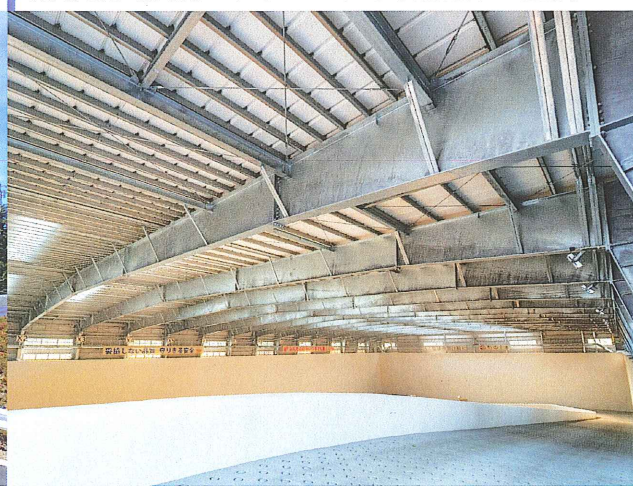
最終処分場内部…アプローチと鉄骨造りの屋根
