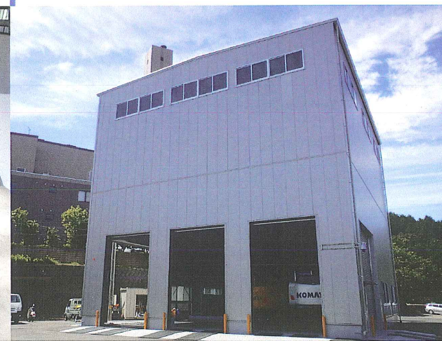
焼却灰セメント混練施設の外観
