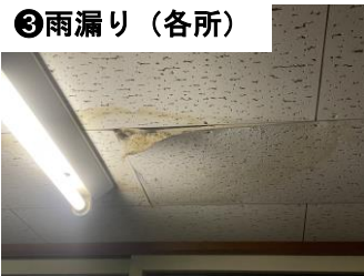
③屋上ひび割れ・雨漏り
