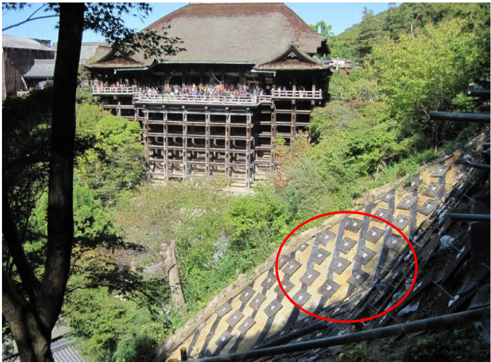
鉄筋挿入工（グリーンパネル）
