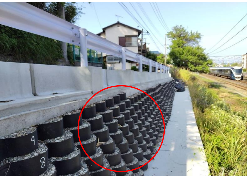
鉄筋挿入工（グリーンパネル）
