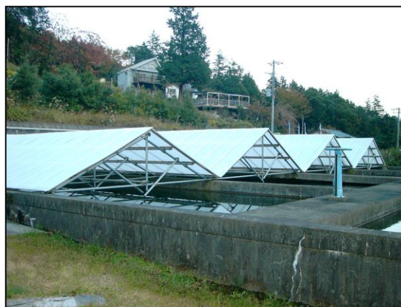
写真 2.2 幕山浄水場内
