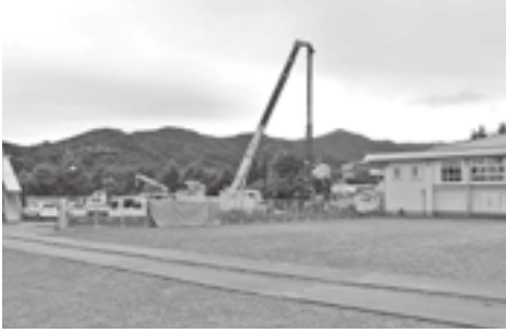
▲(仮称)防災コミュニティセンター建設現場
