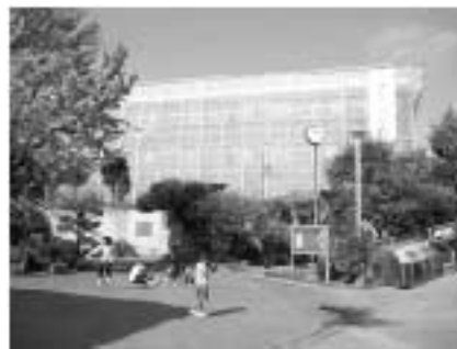
耐震改修工事中の吉浜小学校
