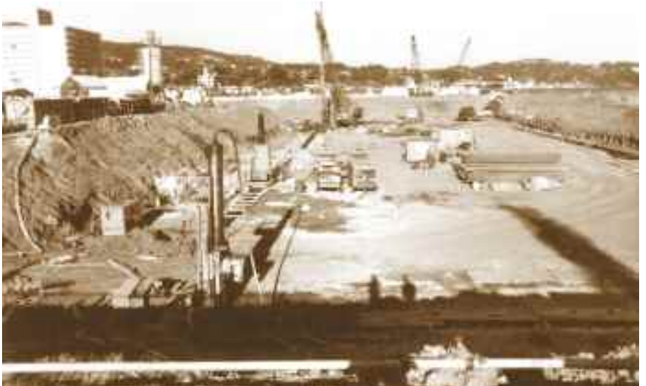
1981（昭和56）年1月 建設中の下水処理場
