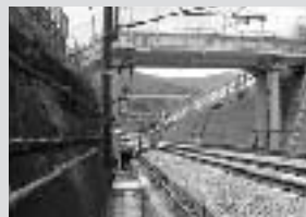
【新幹線跨線橋改良事業】 第1宮下跨線橋における橋脚の耐震補強・落橋防止工事を実施しました。
