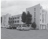
〈教育センター〉 旧湯河原中学校校舎の一部を教育センターとして改修しました。
