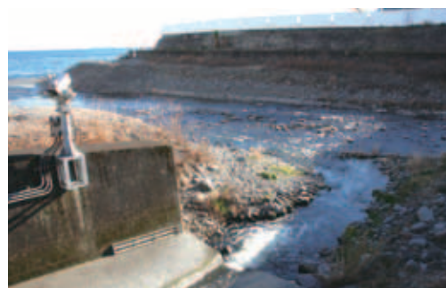
放流水の排水口付近(門川)
