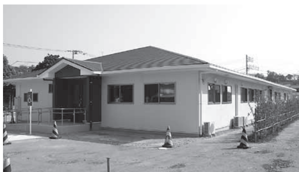
地域福祉センター1号館
