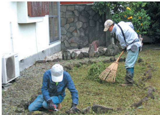
「作業中の様子」
