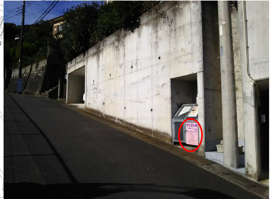
写真（看板設置箇所）
