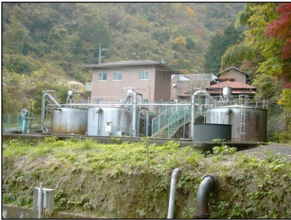
写真 2.111 広河原浄水場急速ろ過機
