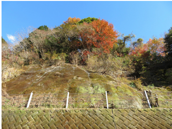
写真 2-1 モルタル吹付
