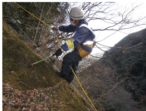
写真 5－1 特定土工点検の状況
